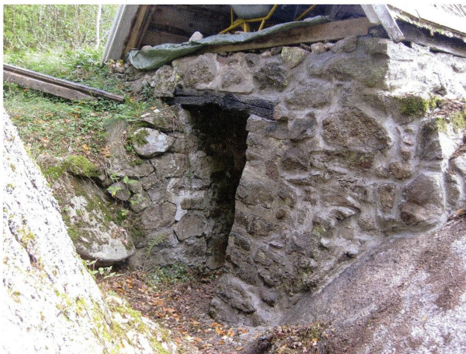
Den gamle stenkælder var med sine en meter tykke mure et solidt fundament at bygge det nye gæstehus på.
